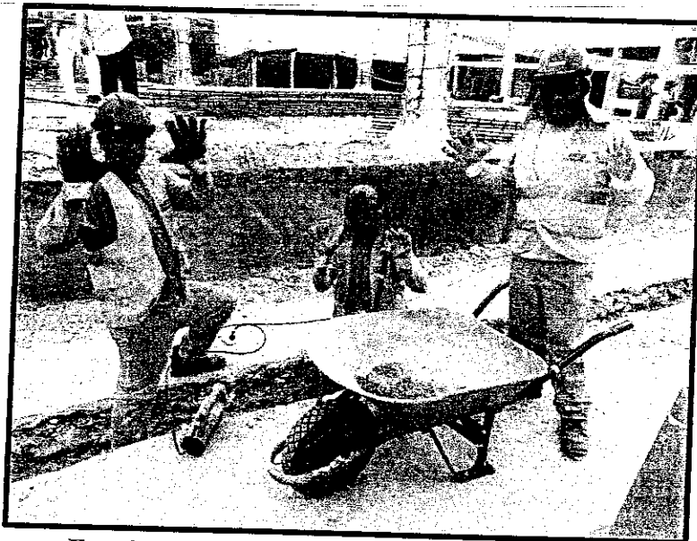
Foto N°29: Los trabajadores con su EPP básico.
