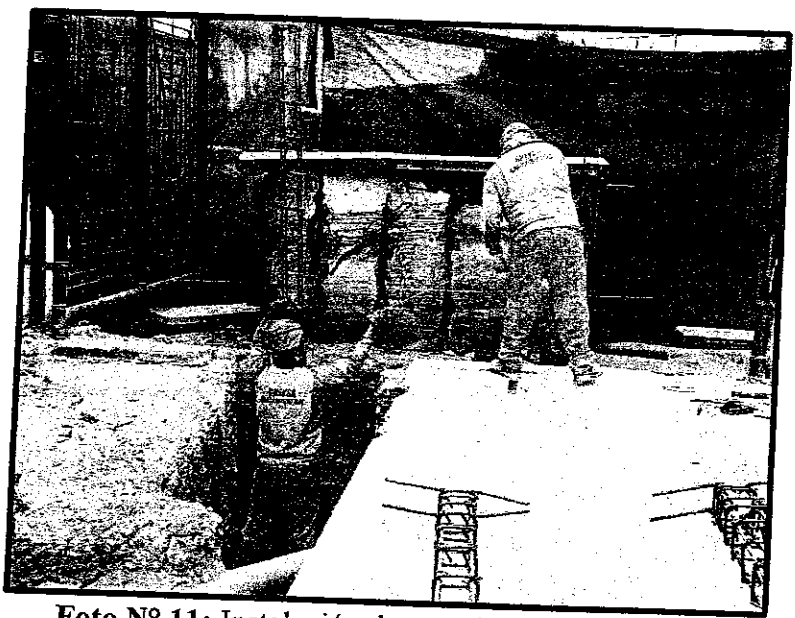
Foto N° 11: Instalación de enmallado de columnas.
