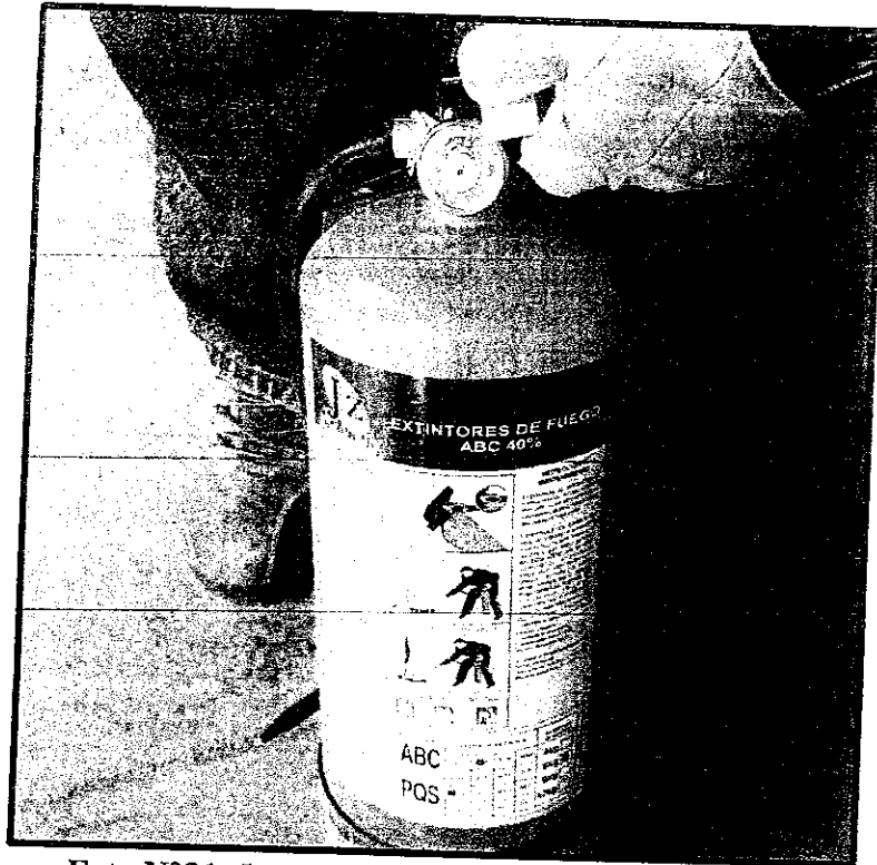
Foto N°31: Inspección de Extintores de Seguridad.
