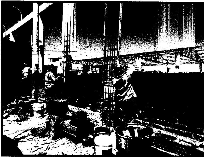
Fotografía N° 08: Asentado de ladrillo del cerco perimétrico.
