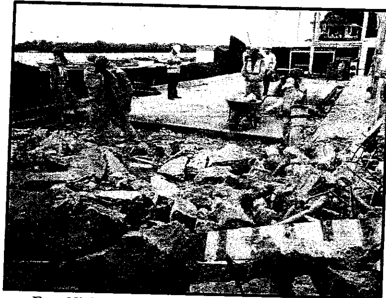
Foto N° 07: Retiro de desmante de forma manual.
