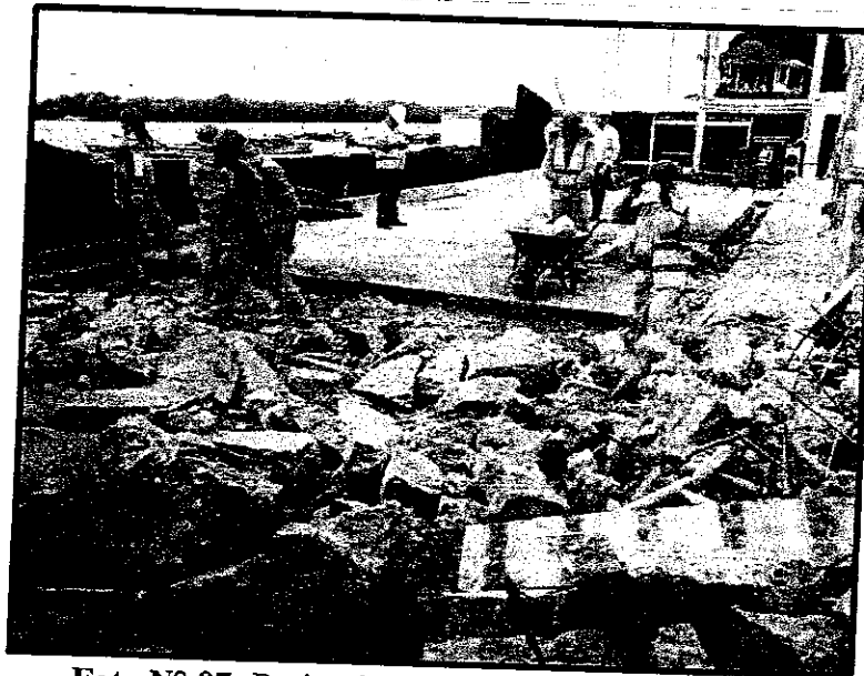
Foto N° 07: Retiro de desmante de forma manual.
