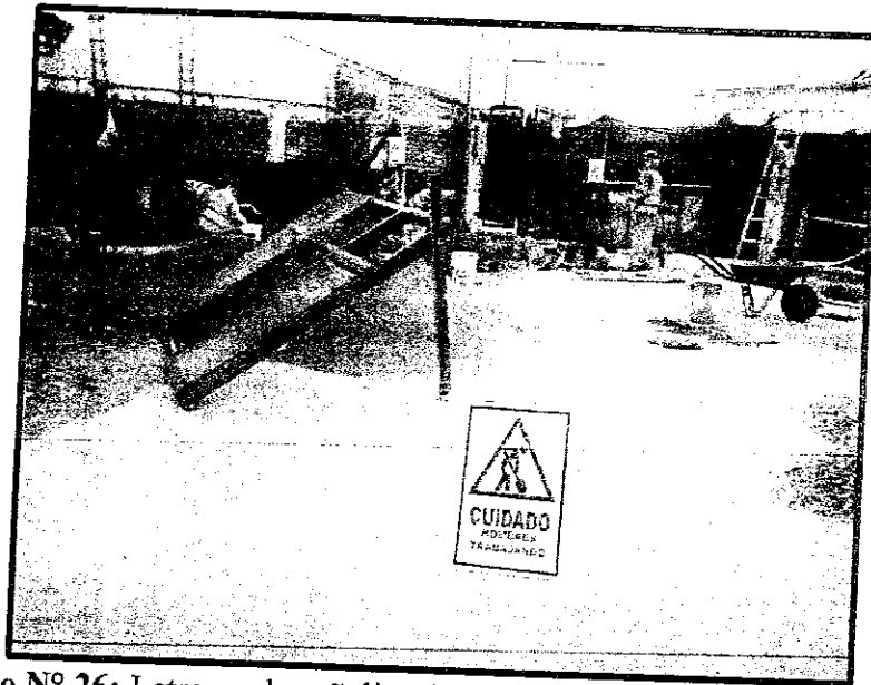
Foto N° 26: Letreros de señalización cuidados hombres trabajando.
