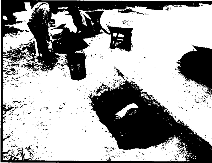
Fotografía N° 07: Excavación de zapatas.
