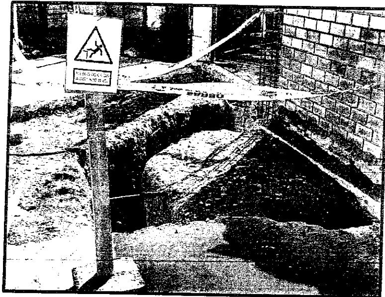
Foto N° 18: Señalética indicando el riesgo de caída a desnivel.
