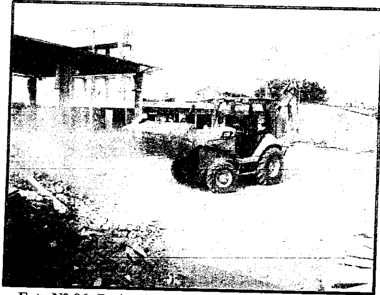
Foto N° 06: Retiro de desmante con Retroexcavadora.
