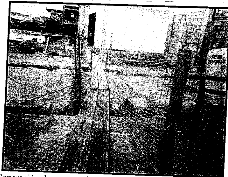
Foto N° 21: Generación de accesos delimitados con mallas y letreros de señalización de pase peatonal.
