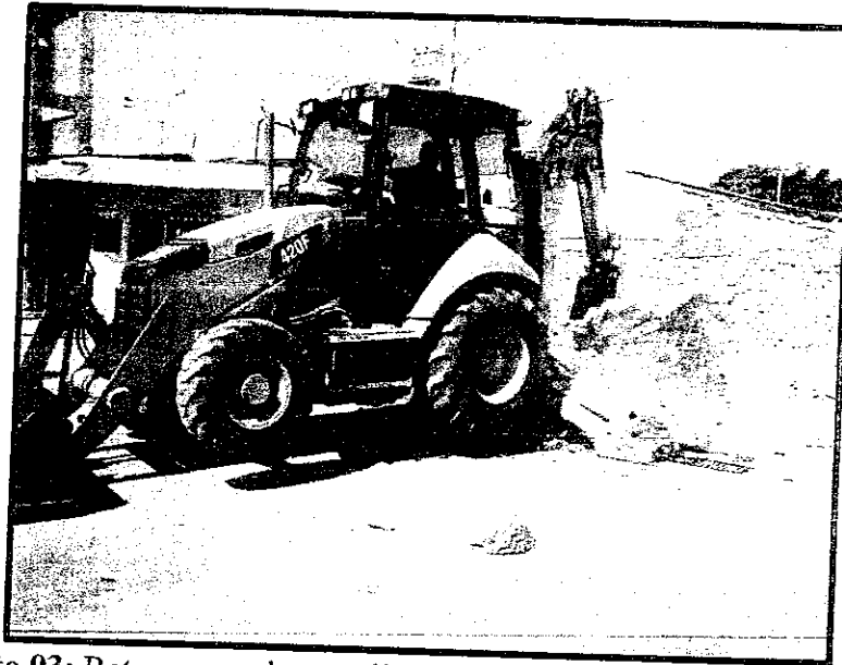
Foto 03: Retroexcavadora realizando actividades de demoliciones.
