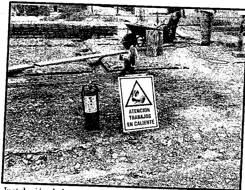
Foto N°27: Instalación de letreros de Trabajos en Caliente y extintor de seguridad.
